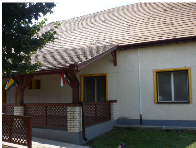
Az Igazgatási irodablokk épülete
