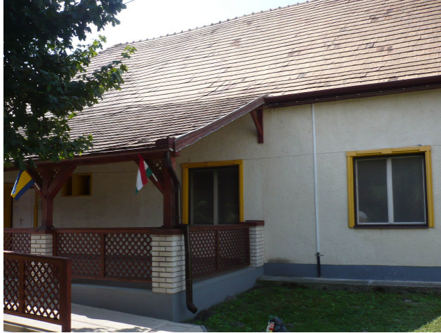
Az Igazgatási irodablokk épülete
